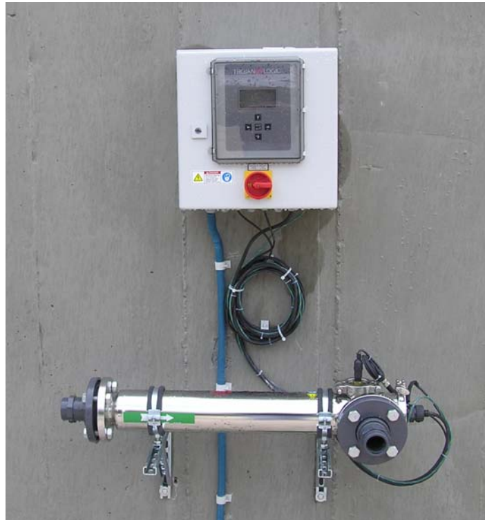
Φωτογραφία 3. Σύστημα απολύμανσης με υπεριώδης ακτινοβολία (UV)
